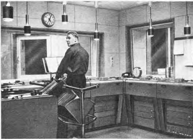
Bild 1. Tonträgerraum im Haupthaus des Deutschlandfunks in Köln-Marienburg
