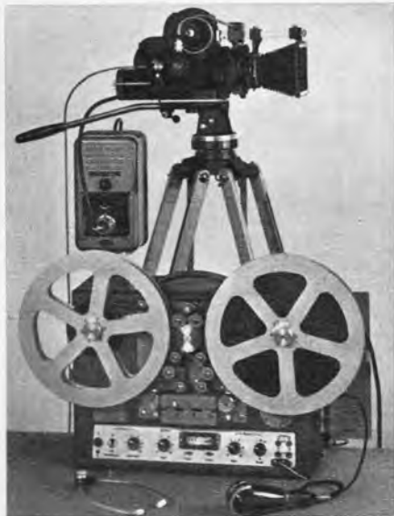
Bild 1. Filmreportage-Ausrüstung mit Siemens-Reportocord 16 M/R und der Arriflex 16 mit Synchronmotor
